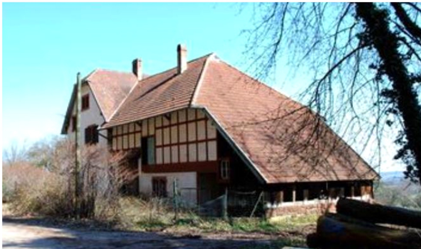
Voici la maison après rénovation :
