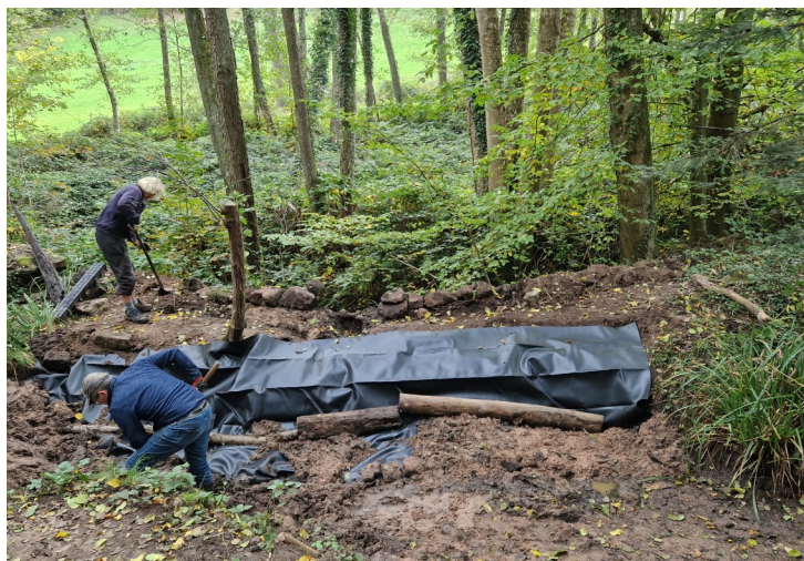
Coup de pelle après coup de pelle le chantier avance
