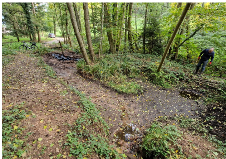
Vue d'ensemble de la mare en cours de travaux
