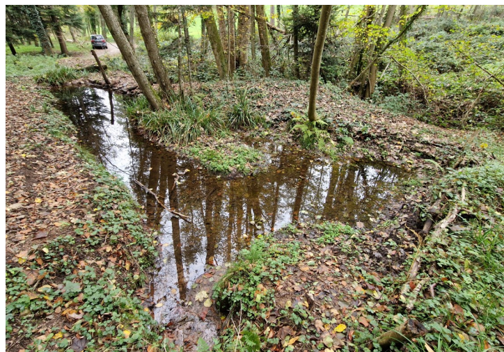
Vue d'ensemble de la mare en fin de travaux
